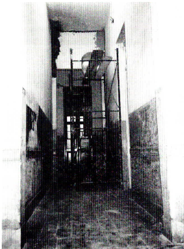
Primer piso: Pasillo entre la Biblioteca y la Sec. de Postgrado.
