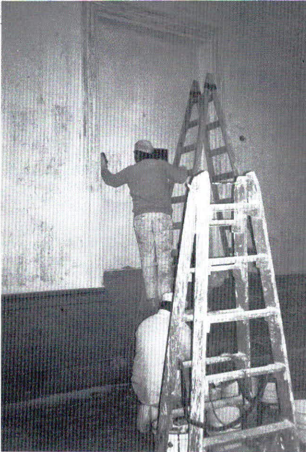
Reparación integral, en este caso, de las paredes del acceso al Edificio Central.
